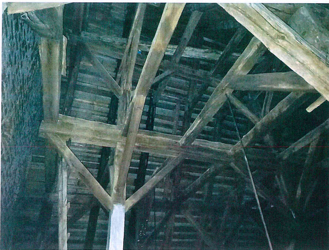
Fot. 3. Drewniana konstrukcja więźby dachowej stabilna, płatwie, stolce, krokwie, krzyżulce miecze i inne elementy w stanie technicznym dobrym, surowe drewno zaleca się zaimpregnować przeciw grzybiczo i przeciwogniowo przez pomalowanie specjalistycznymi preparatami przeznaczonymi do tego celu.
