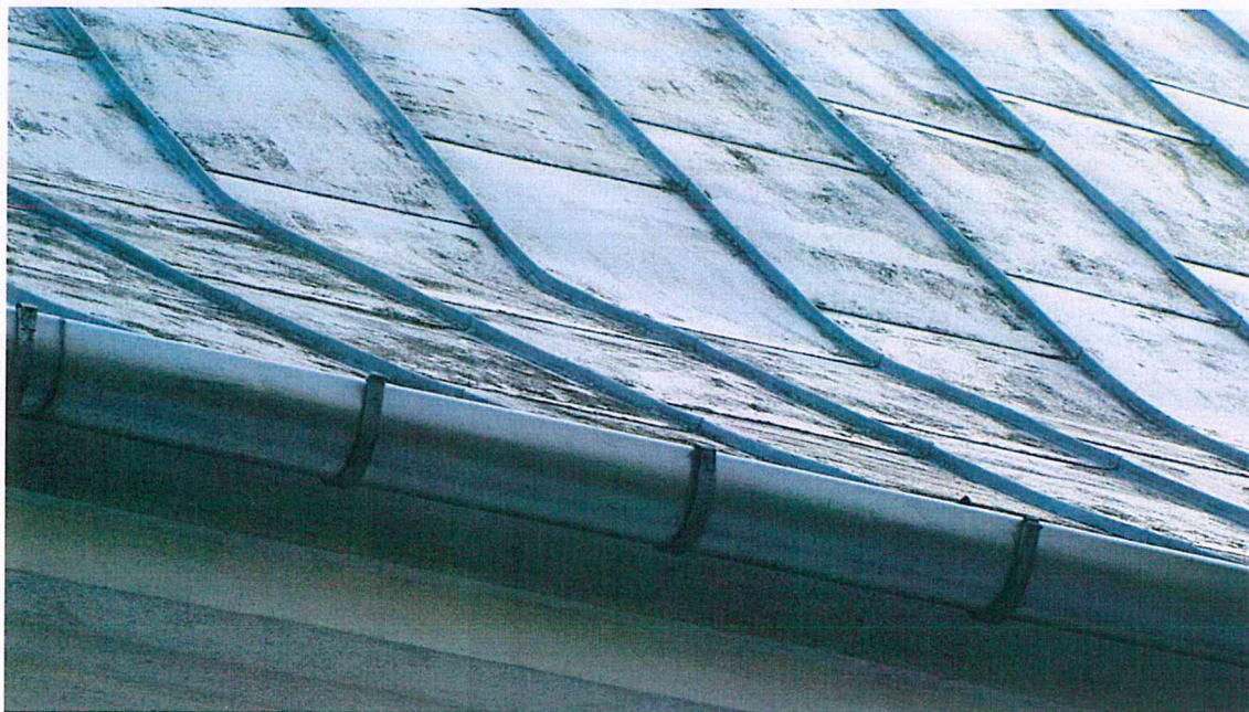
Fot.7. Blacha zniszczona, z widocznymi wykwitami korozji chemicznej i biologicznej, nadaje się do wymiany.
