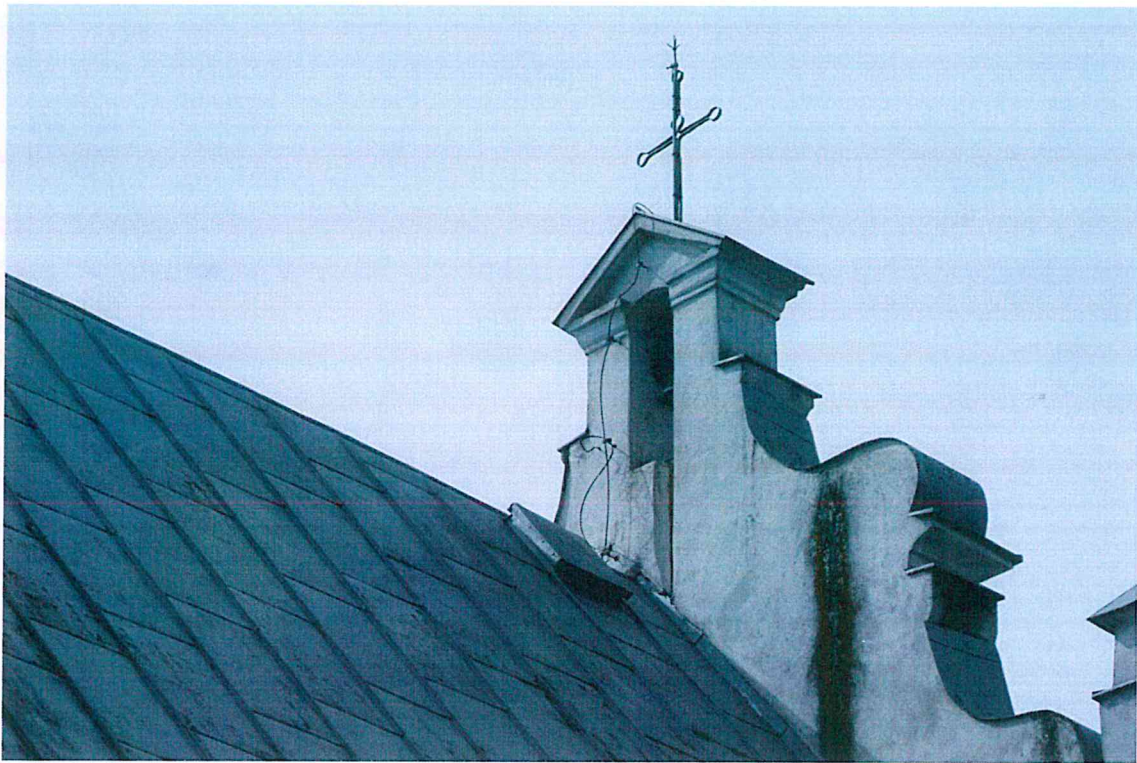
Fot.8. Fragment dachu z widocznymi zniszczeniami obróbek blacharskich.
