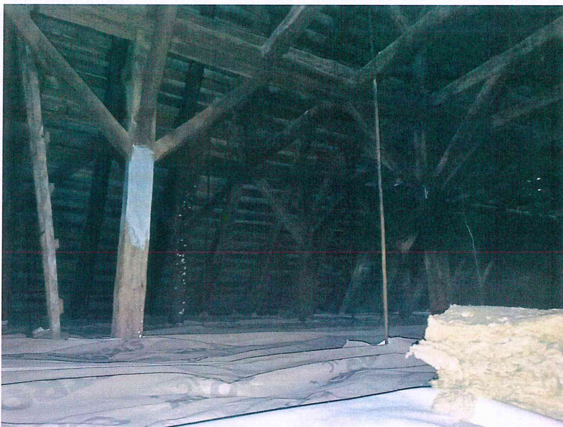
Fot.5. Więźba dachowa nie wykazuje oznak braku stateczności.
