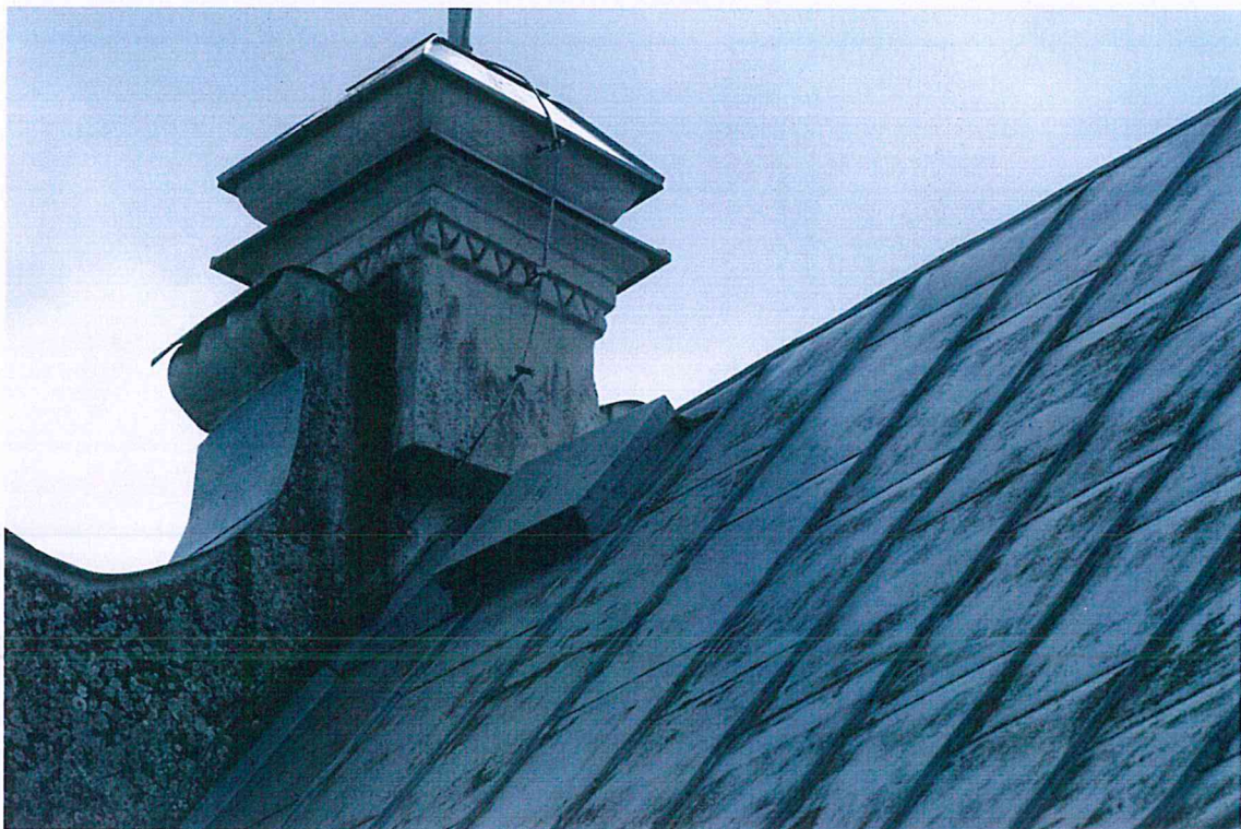
Fot.9. Fragment zwieńczenia fasady elewacji i połaci dachowej z widocznymi uszkodzeniami blachy wywołującymi podciekanie wód opadowych i niszczenie murów zabytku.
