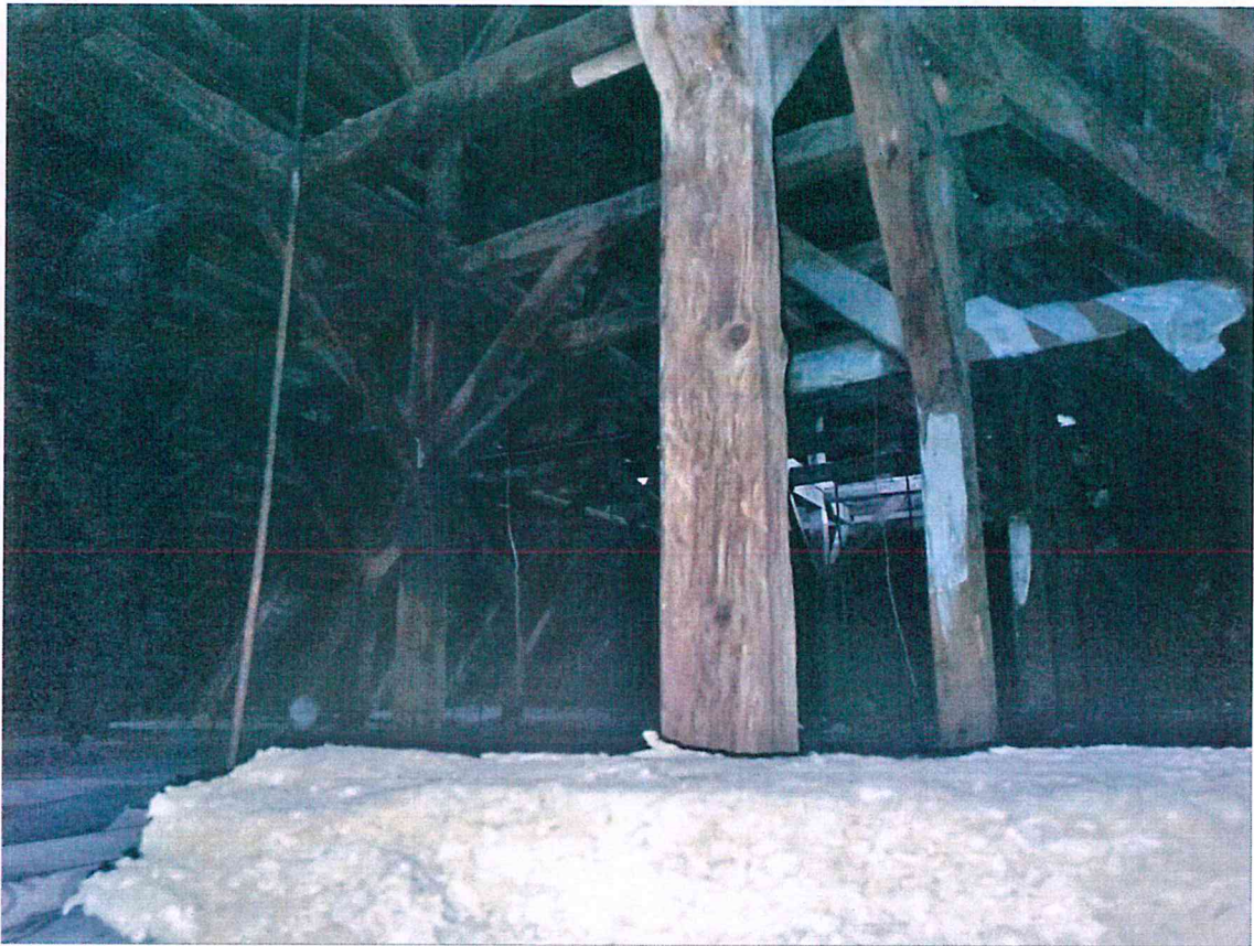
Fot.2. Widok drewnianej konstrukcji wieży kościoła w Bobrownikach, nie stwierdzono ugięć, załamania lub innych uszkodzeń świadczących o braku stateczności konstrukcji.
