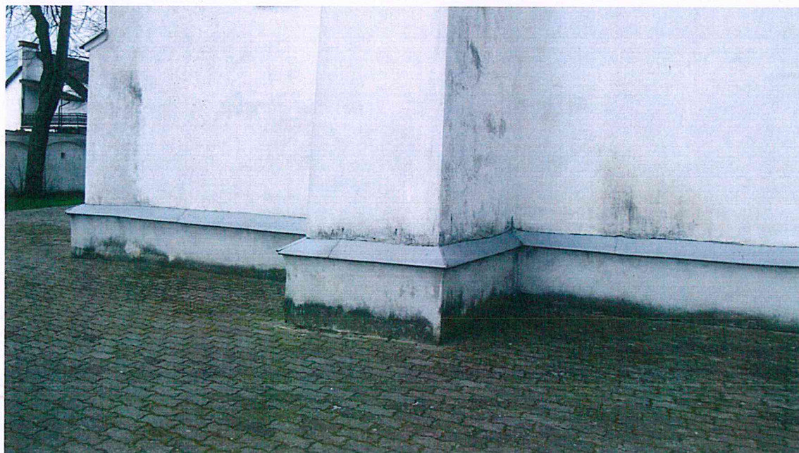
Fot.11. Obróbki blacharskie cokołu odkształcone, nie chronią murów przed migracją wód opadowych.
