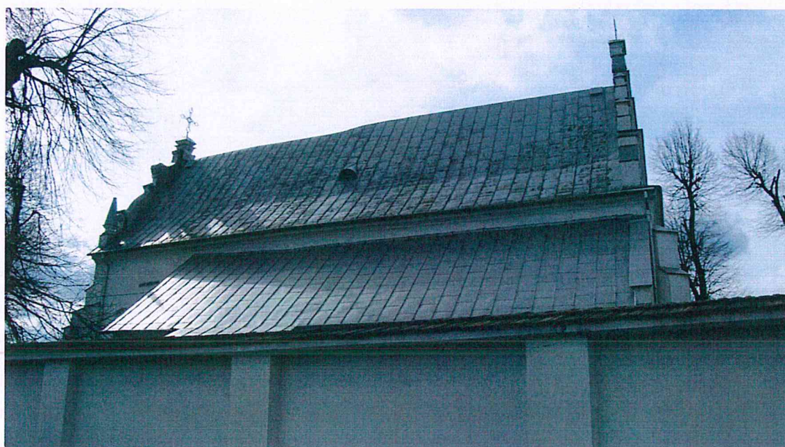
Fot.6. Pokrycie więźby dachowej kościoła oraz przybudówek stanowi blacha płaska, której stan techniczny jest niezadowalający, widoczne są liczne ogniska korozji. W 1970 roku wymieniono pokrycie dachowe na blachę ocynkowaną, w 1987 roku przeprowadzono konserwację dachu, z
